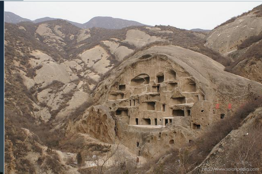
En China mucha gente construye casas excavando en el loess
