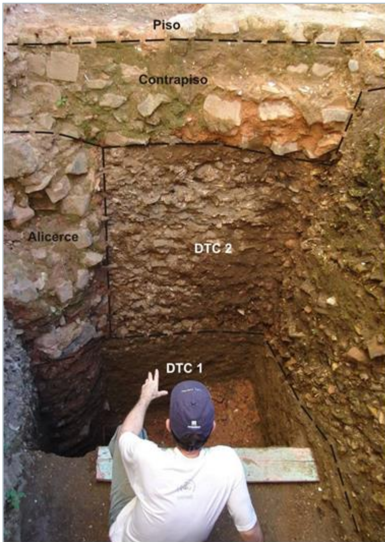
Fig. 6. Deposición del DTC 1, DTC 2, cemento, contrapiso y piso. Notar a la derecha de la foto la continuidad lateral de los DTCs. Casa 41 Bloque 31S
