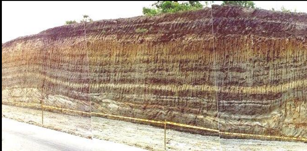
Corte carretera Pereira-Armenia Vertiente Occidental Cordillera Central
