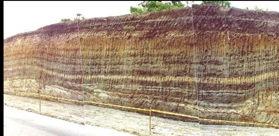
Corte carretera Pereira-Armenia
