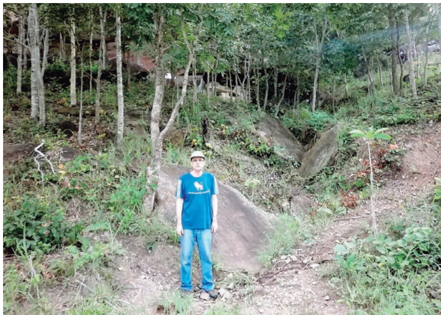
Figura 9 – Processo erosivo na base do talude junto ao sítio arqueológico GO-CP-04. Município de Palestina de Goiás, Goiás.
