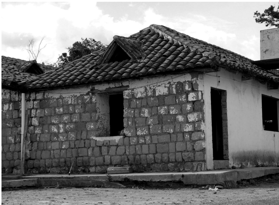
Figura 6. Casa en uso, en la población de Alangasí (valle de San Rafael, provincia de Pichincha), con estructura de bloques de cangahua enlucidos (imagen cortesía Érika Muñoz).
